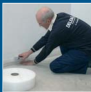
Pose de la bande de pourtour et des panneaux d'isolation
