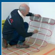
Répartition optimale de l'élément chauffant Infralisse® sur toute la surface (ici changement de direction du câble)
