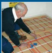
Pose des agrafes pour fixation de l'Infralisse® avant enrobage dans la chape
