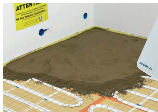
Pose des éléments chauffants Infracable
