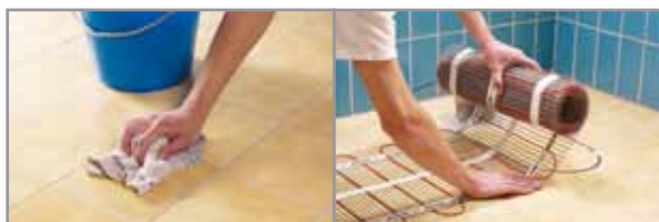
1 La surface de pose doit être parfaitement nettoyée pour une adhérence maximale
