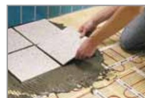
5 Il ne reste plus qu'à poser la surface carrelée
