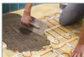
4 Il suffit simplement de recouvrir Confortmat™ STE avec la colle à carrelage
