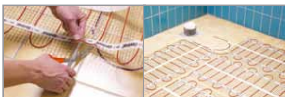
3 Confortmat™ STE offre toute souplesse pour couvrir au mieux les surfaces les plus exigües
